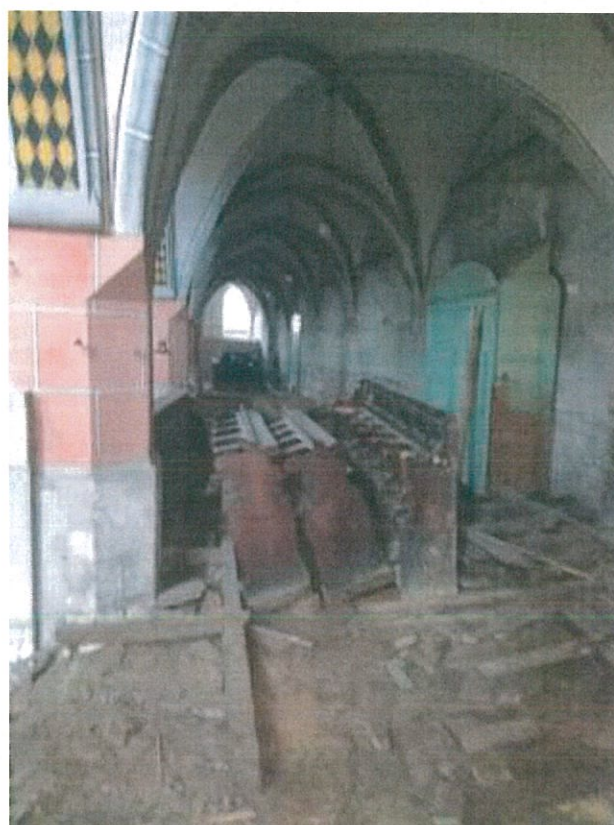
Foto nr. 51: Stuctura podinei așezate pe pământ
