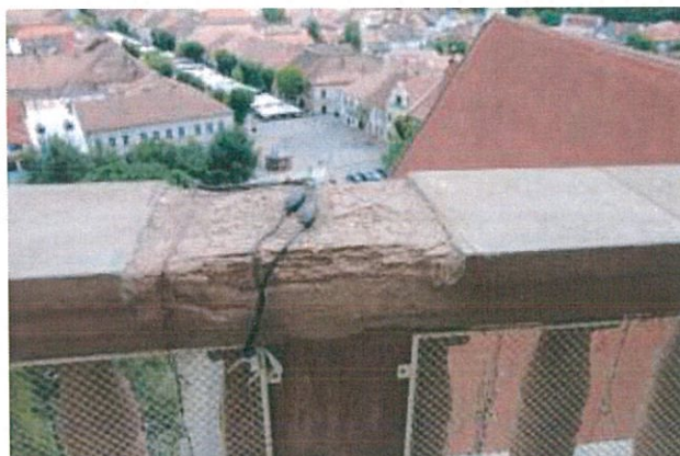
Foto nr. 29: Mâna curentă balustradă turn degradată
