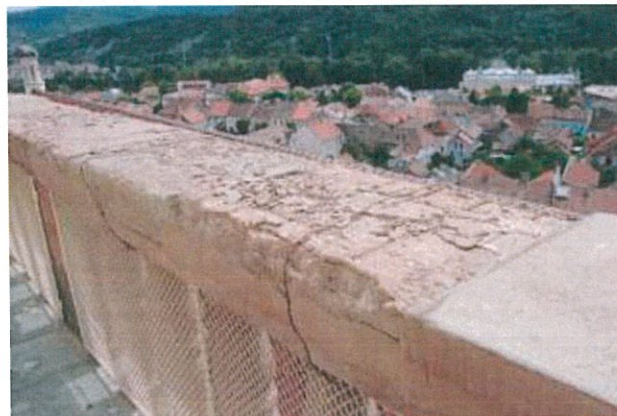
Foto nr. 30: Mâna curentă balustradă turn degradată
