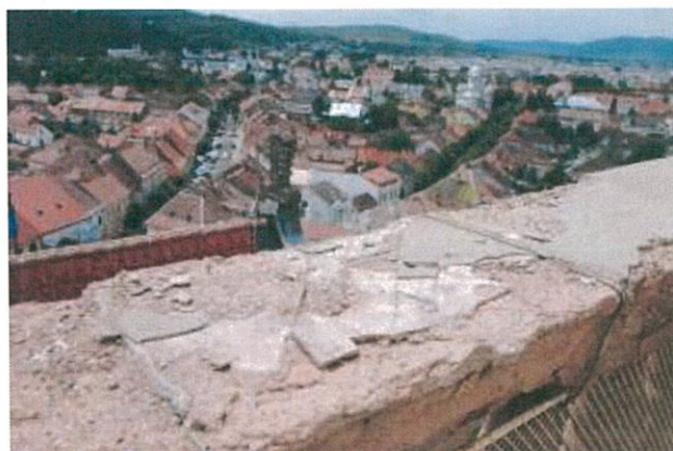
Foto nr. 27: Mâna curentă balustradă turn degradată
