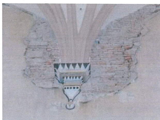
Foto nr. 21: Consolă de boltă din piatră
