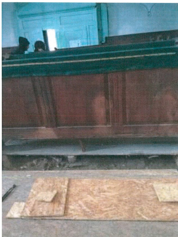
Foto nr. 50: Stuctura podinei așezate pe pământ
