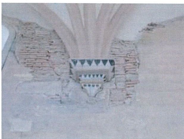
Foto nr. 20: Consolă de boltă din piatră
